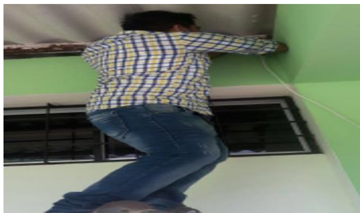
Figura 9. Implementación del sistema de videovigilancia: Ruteo de cable para la cámara CAM-003 ubicada en el centro de cómputo.
