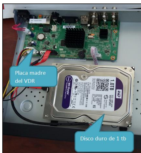
Figura 10. Implementación del sistema de videovigilancia: Instalación del disco duro en el DVR.
