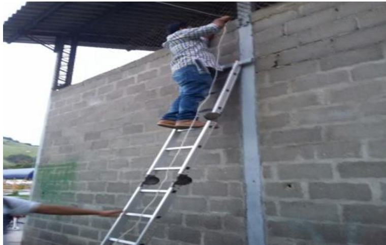
Figura 7. Implementación del sistema de videovigilancia: Ruteo de cable para la cámara CAM-002 ubicada en el taller automotriz
