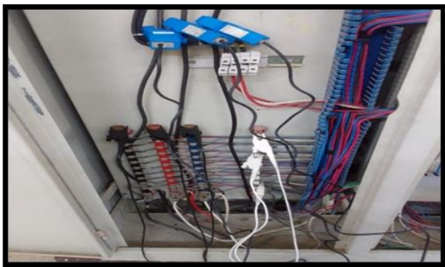
Figura 2. Correcta conexión de los conectores del Analizador DRANETZ HDPQ VISA.
