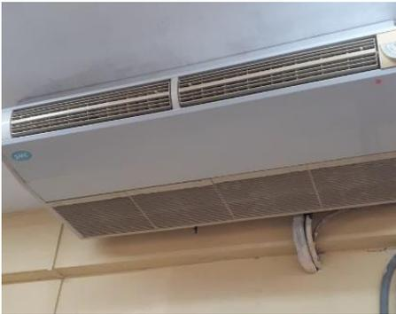
Figura 11. A/C del laboratorio de 36000 BTU.
