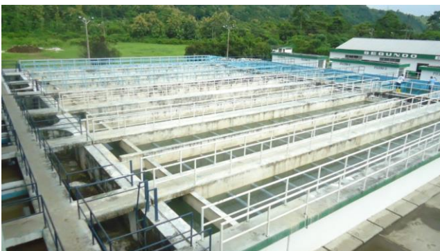
Figura 6. Sedimentadores
