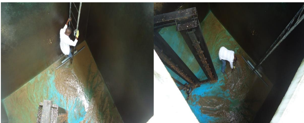
Figura 18. Extracción del lodo en floculadores
