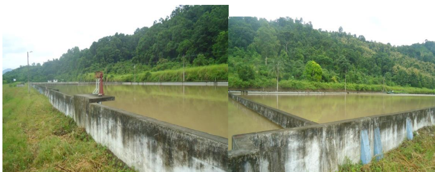
Figura 3. Piscinas de Presedimentación.
