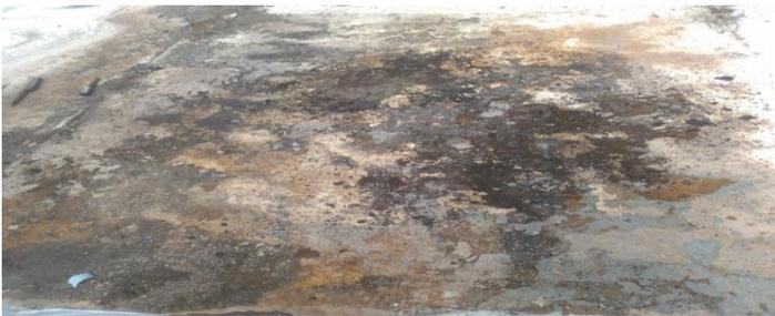
**Figura 6.** Techo de tanque- ataque por bacterias
