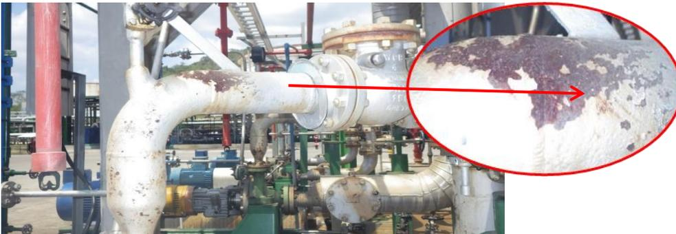
**Figura 3.** Línea de descarga de una bomba con sus respectivos accesorios- corrosión localizada (Refinería de Esmeraldas, 2017)
