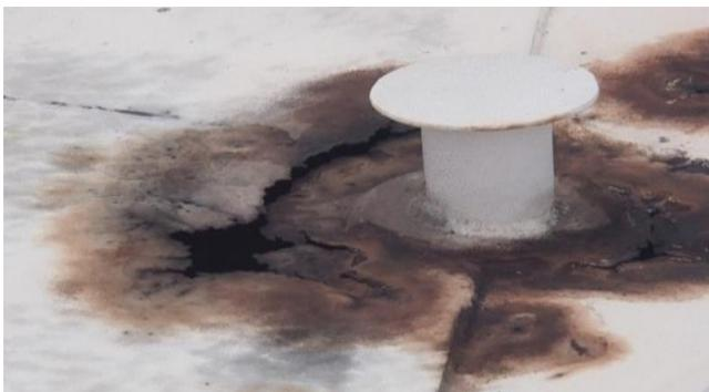
**Figura 4.** Techo de tanque – corrosión galvánica (Refinería de Esmeraldas, 2017)
