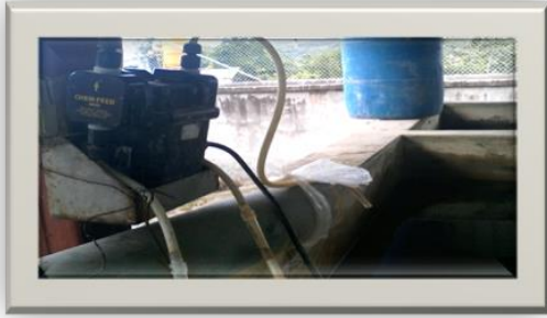
Figura 2. Bomba dosificadora de químicos
