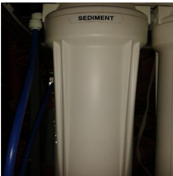
Figura 2. Filtro de sedimento de 5 micras.
